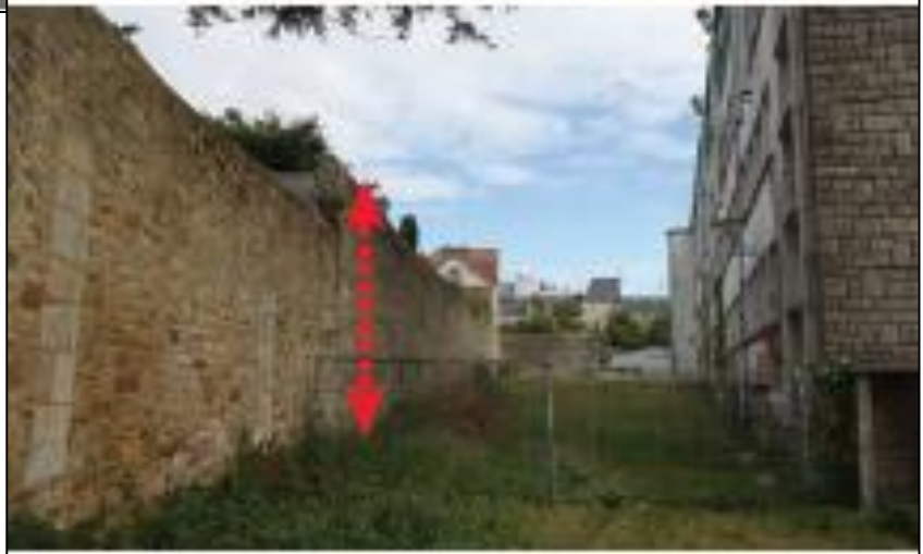
Murs de soutènements en pierre @Rapport d'étude 2021 - CAUE
