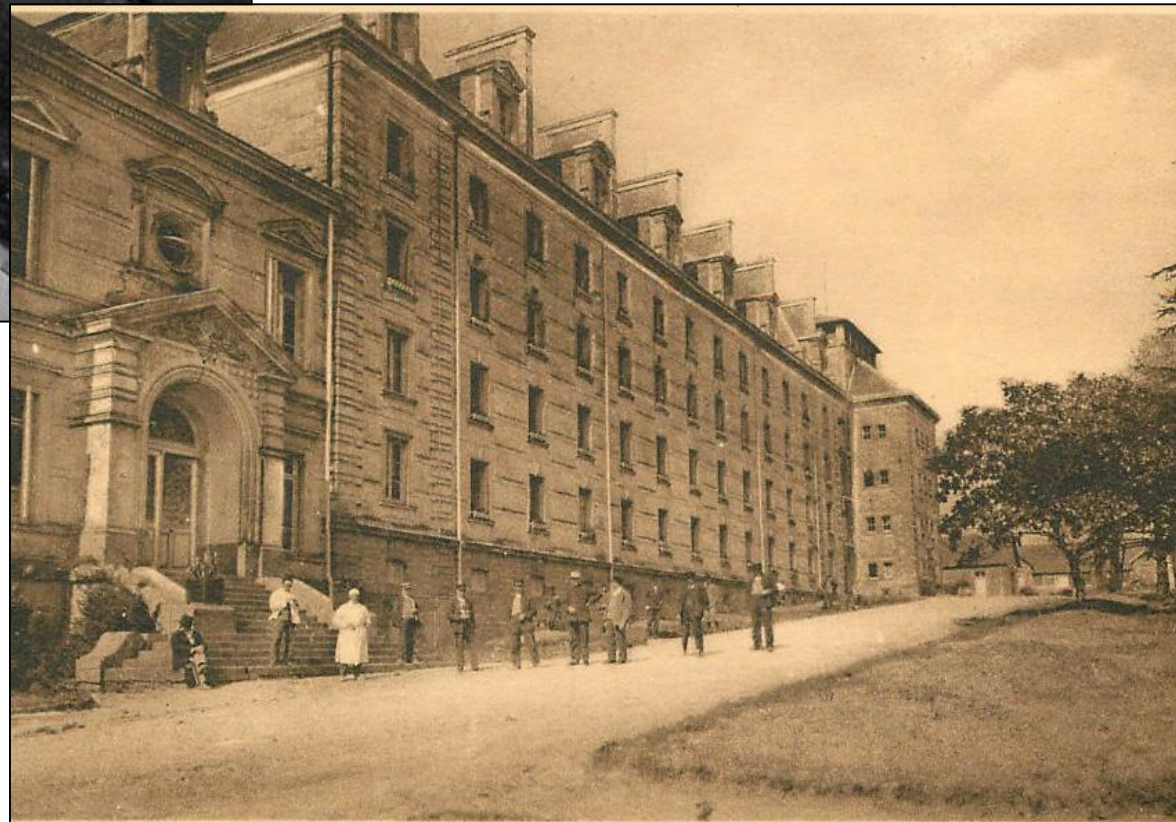
Aspect de la façade de l'ancien séminaire- 1952 @ Rapport d'étude 2019 - CAUE
